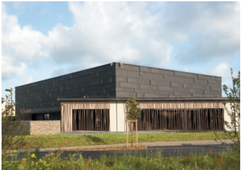
Salle Polyvalente, Saint Avé (France) - Architecte : Archipole Rennes - Entreprise : Quemard
