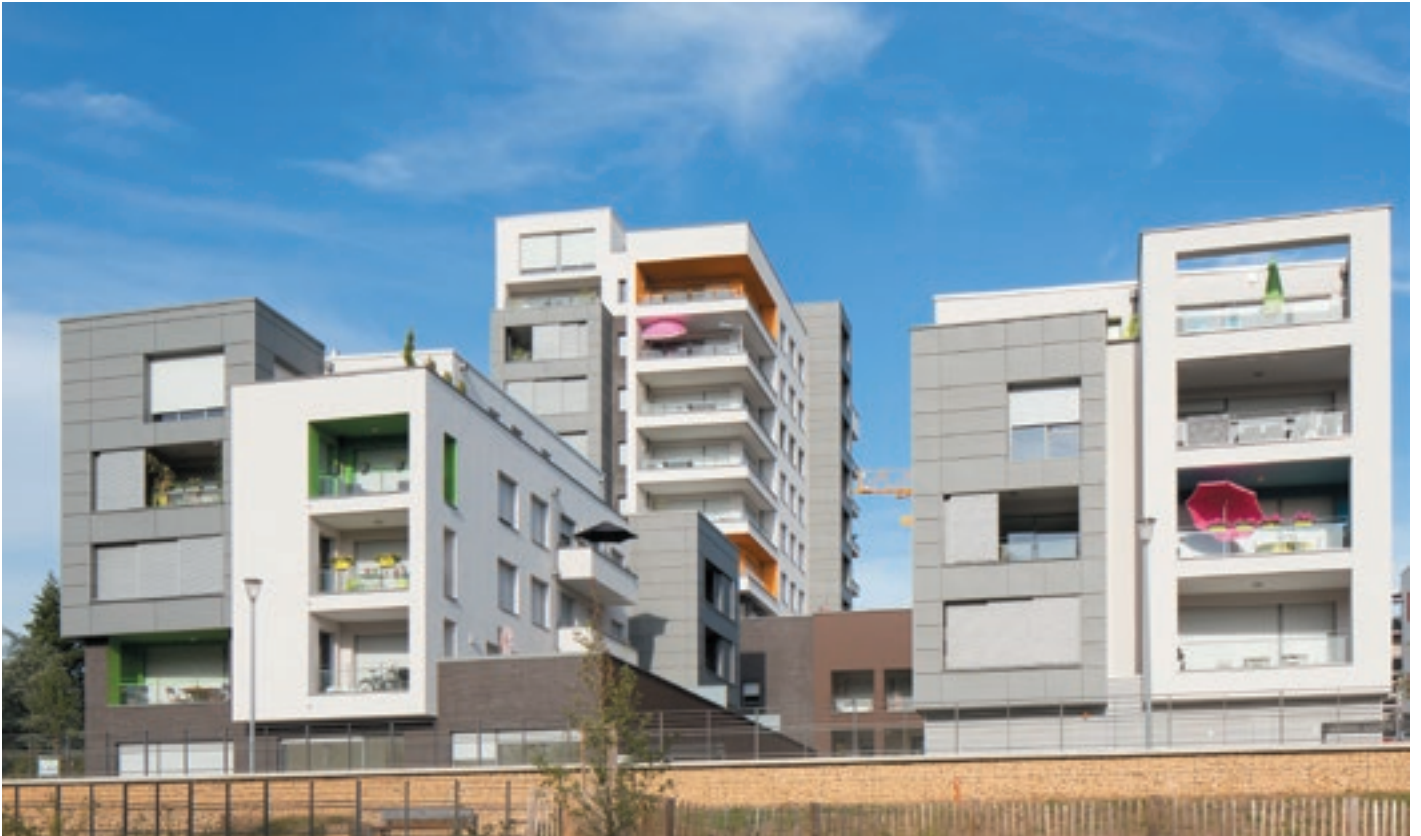
Residences les Panoramiques, Metz (France) - Architecte : Dynamo Associés M Hein - Entreprise : Maddalon
