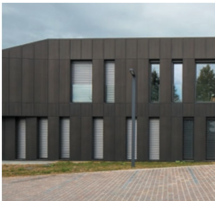
Maison de santé, Crécy-sur-Serre (France) - Architecte : Gissinger + Tellier Architectes. Entreprise : Caron SA
