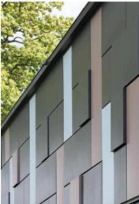
Locaux Entreprise Le Lorec Couverture, Marsac sur Don (France)
